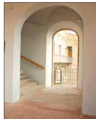
Fig. 4 Le loggiate dei Governatori e sullo sfondo l'accesso alla scala elicoidale
